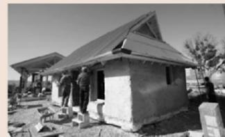
Fase di intonacatura delle balle portanti
