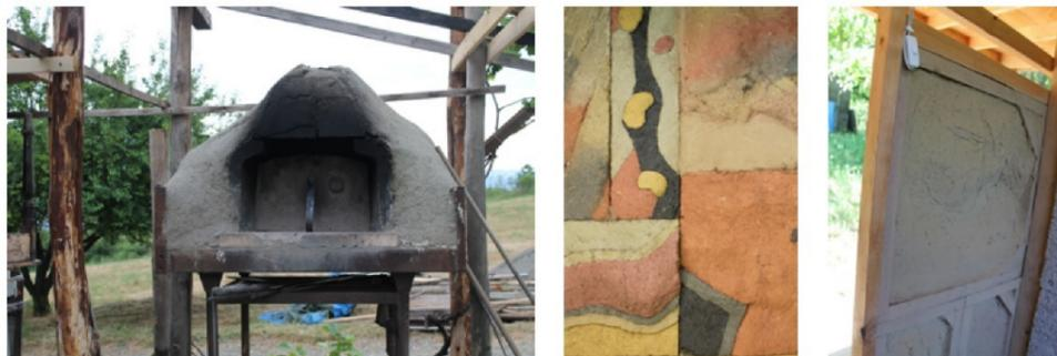
Una delle qualità più importanti della terra utilizzata come materiale da costruzione è la capacità di immagazzinare il calore e rilasciarlo lentamente. Proprio per questo risulta un materiale perfetto per la costruzione dei forni. A differenza dei forni casalinghi che lavorano principalmente per convezione, il forno in terra lavora sia per convezione, sia per irraggiamento che per conduzione.
