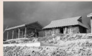
Posizionamento balle e copertura completato
